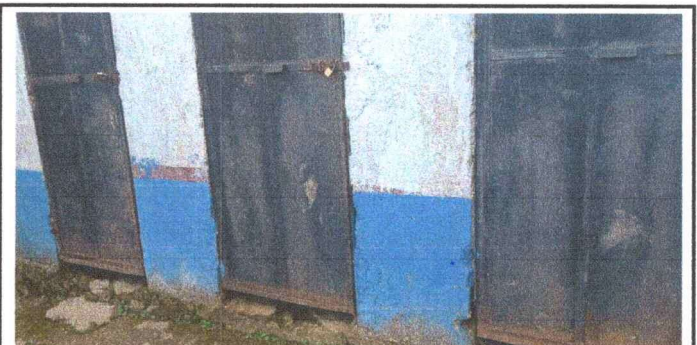
Foto 6: Se observa deterioro de pinturas en las puertas.
